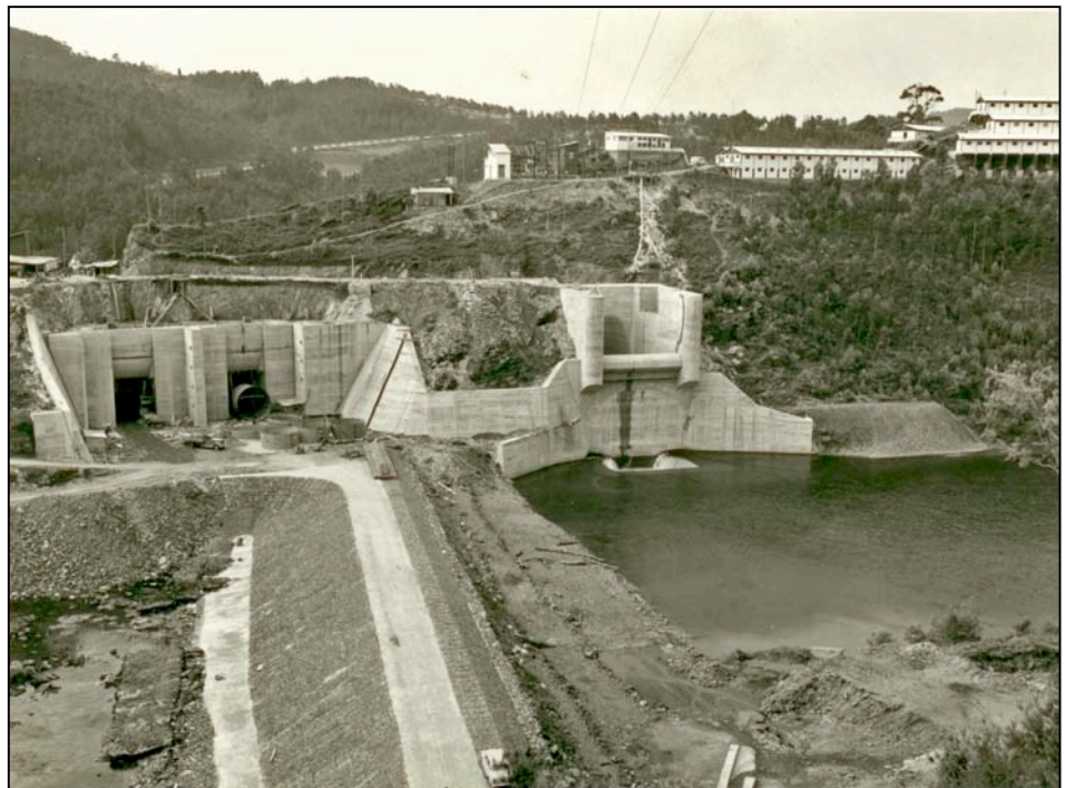
Construcción de la presa a mediados de la década de 1960
